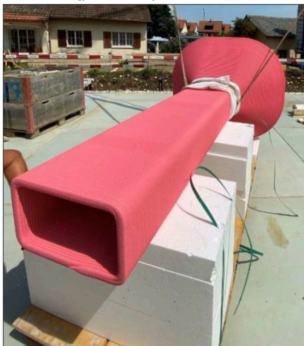
16. ábra: Előregyártott beton nyomatással készült zsaluzat (SIKA 3D concrete printing, 2022)
