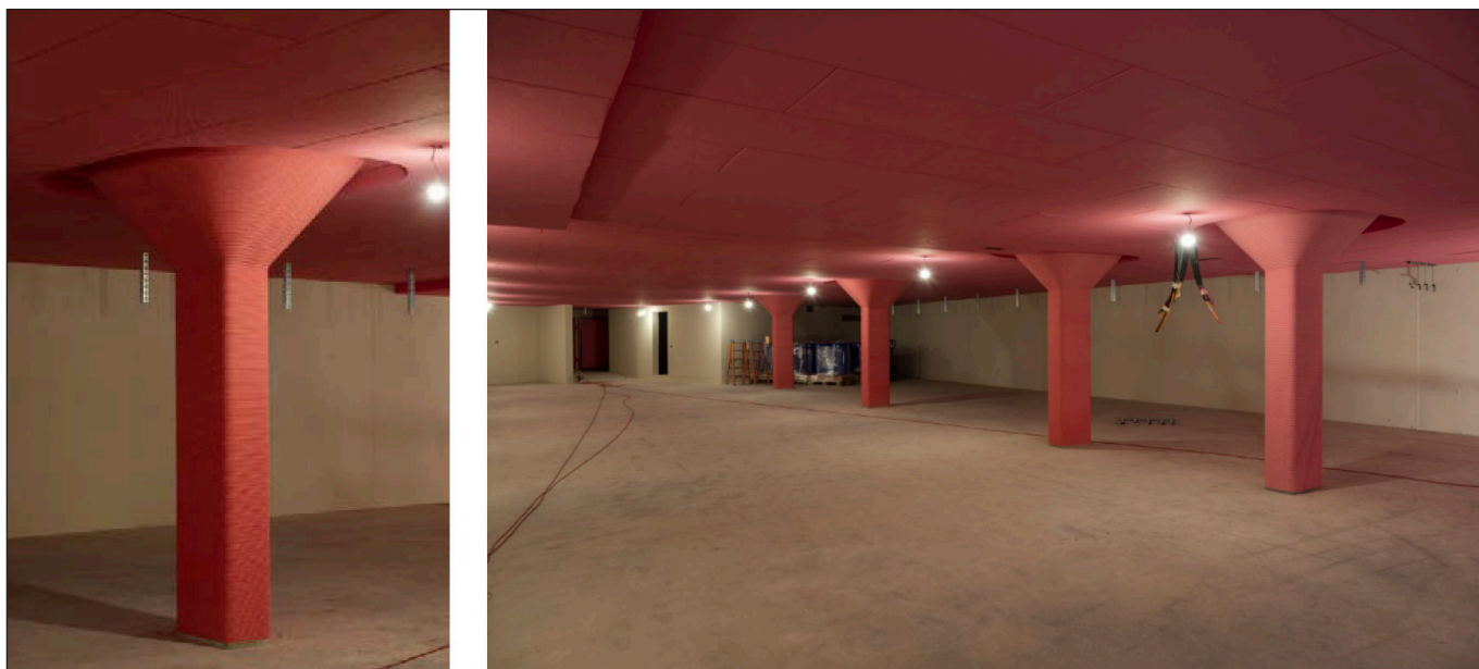
17. ábra: Beépített nyomtatott beton zsaluzat (Schalungen für Stützen in Beton, Stützen mit Pilzkopf, dekorative Stützen, 2022)
