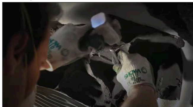
11. ábra: Betonozás utáni roncsolásos zsaluzat eltávolítás (The Smart Slab, 2022)
